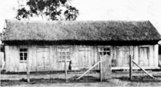
Primer edificio administrativo de la colonia, Volendam.
