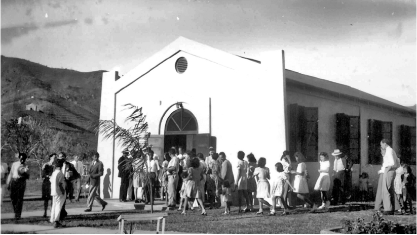
Inauguración de la capilla del MCC, La Plata (1946).
