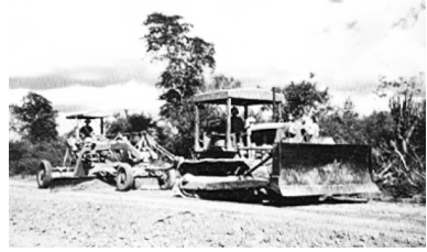
Trabajos de nivelación en la carretera Transchaco.
