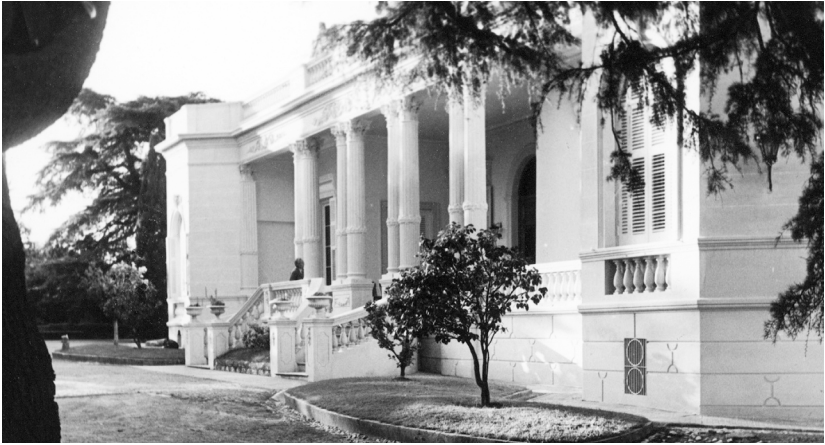
Edificio del Seminario en Montevideo, 1961.
