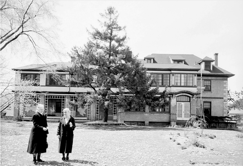
El Hogar Braeside, en Preston, Ontario, en 1952, un «hogar para ancianos» abierto en 1942 por la Convención Menonita de Ontario. El hogar acogía hasta veinticinco ancianos a la vez, hasta que en 1956 fue reemplazado por otra instalación más grande.
